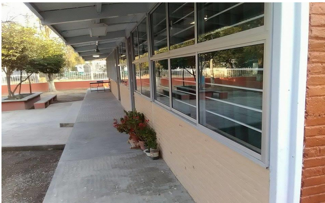
Anexo I Aulas de la escuela primaria “Ignacio Zaragoza”
